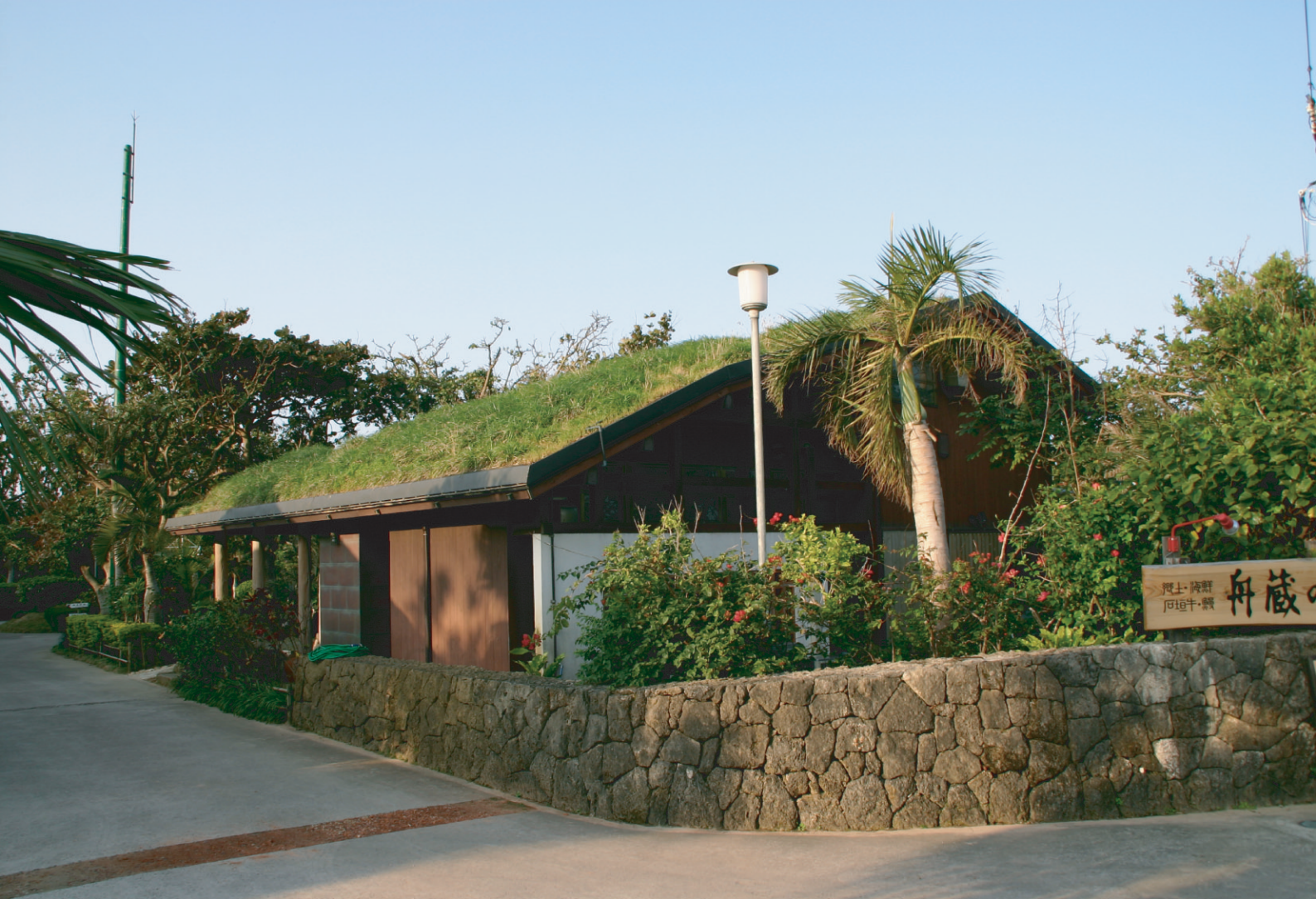
舟倉の里（沖縄県）／工法：ウェットジェット
