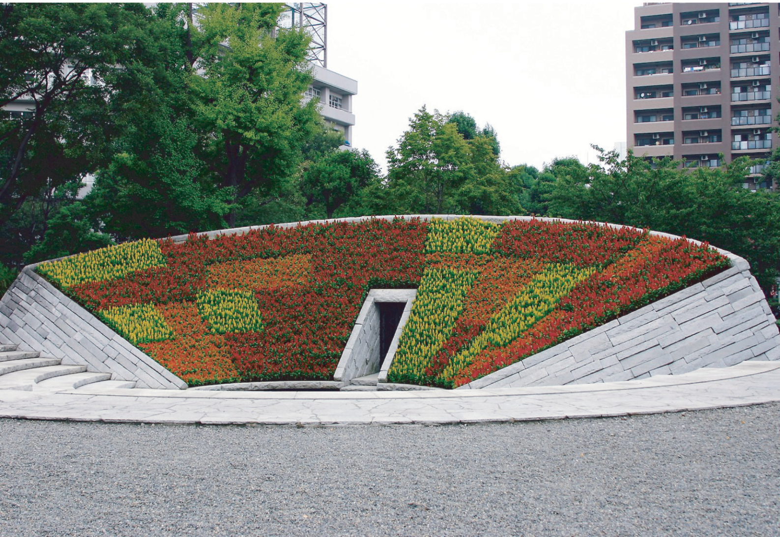
東京空襲犠牲者追悼平和モニュメント（東京都）／工法：ウェットジェット
