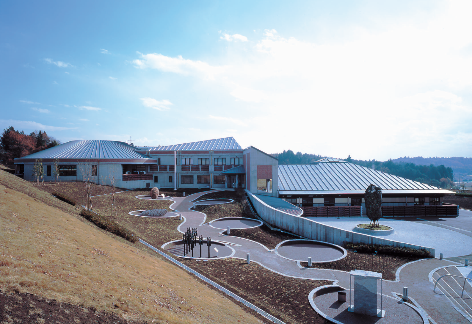
工業技術センター 窯業指導所（茨城県）／工法：プロムナールーフ（化粧リブ付）
