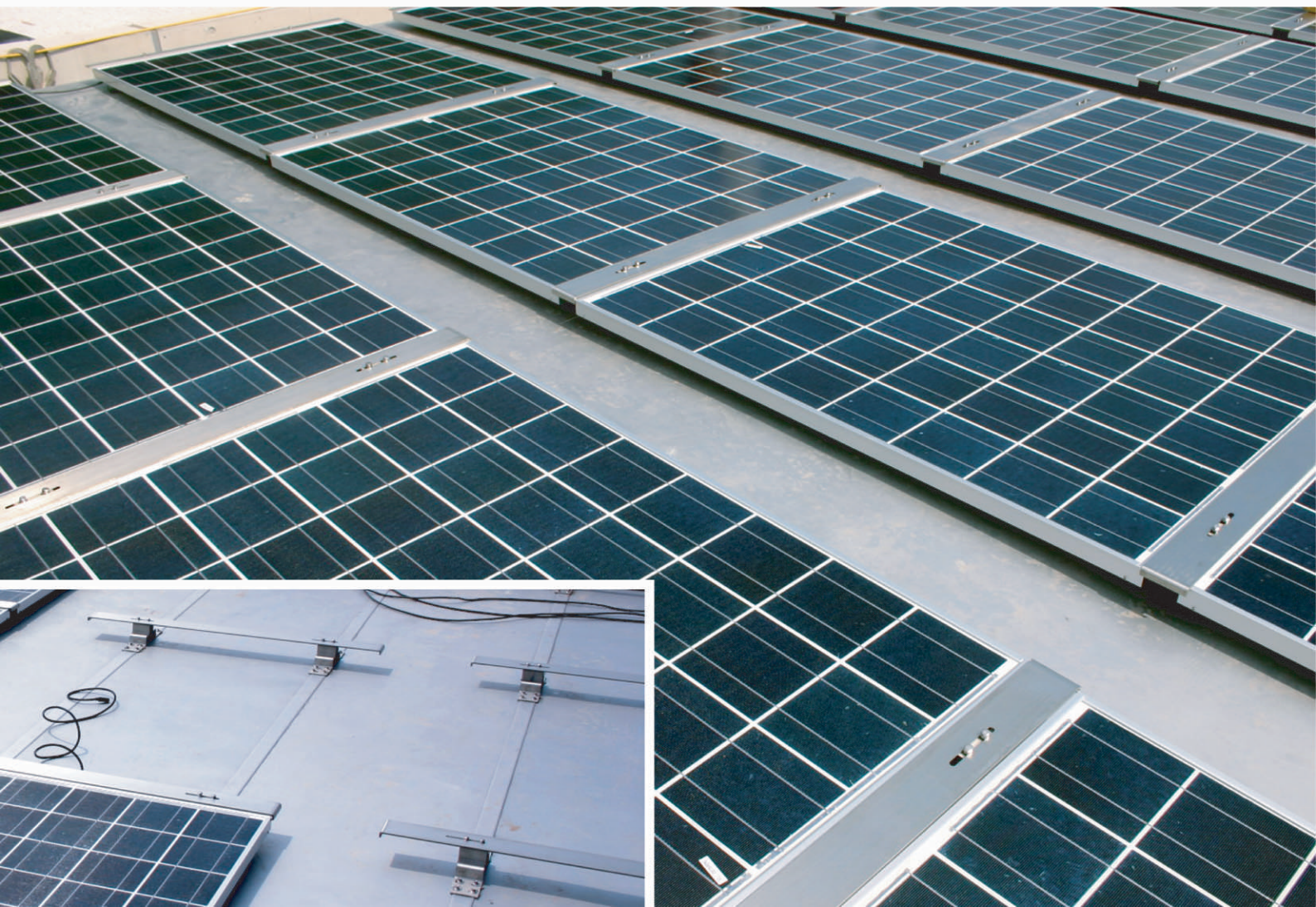
大和ミュージアム（広島県）／工法：プロムナールーフ（太陽光発電パネル設置）
