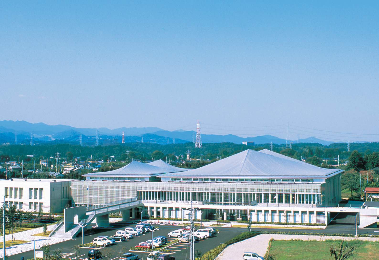
日高市総合体育館（埼玉県）／工法：プロムナールーフ
