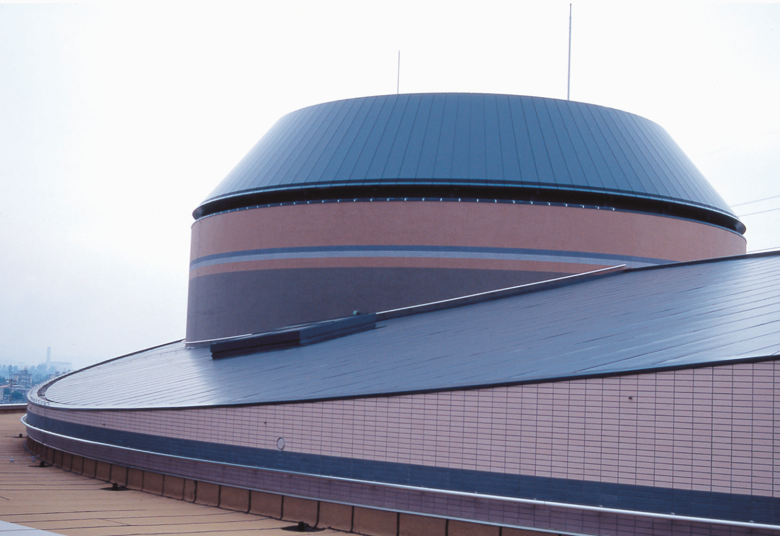
岡山ふれあいセンター（岡山県）／工法：プロムナールーフ
