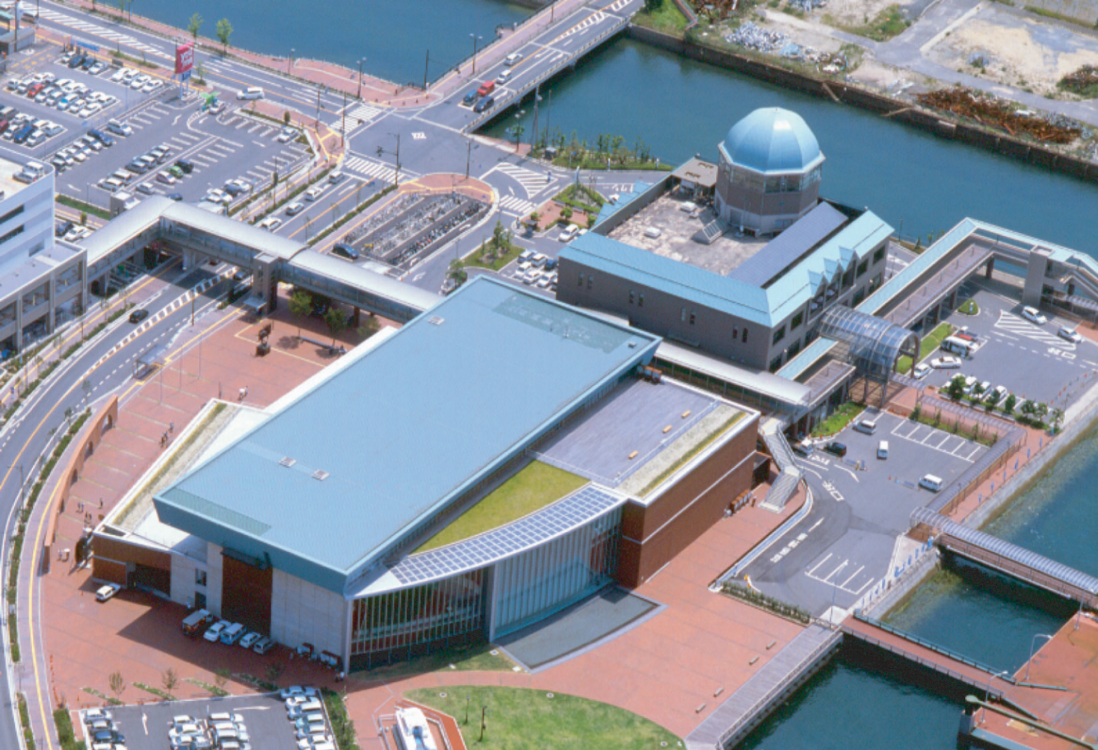
大和ミュージアム（広島県）／工法：プロムナールーフ（太陽光発電パネル設置）
